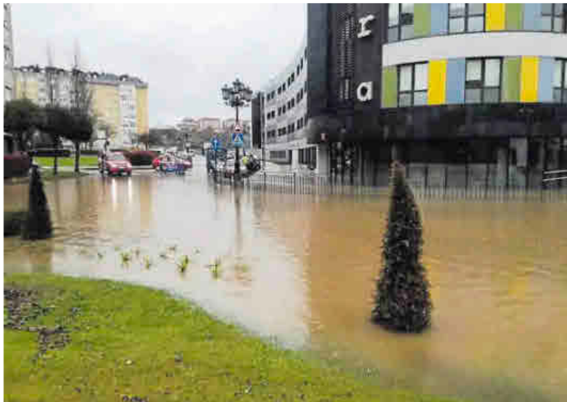
La rotonda de Cerdeño, anegada por las lluvias en 2018 a causa de la borrasca «Hugo».
